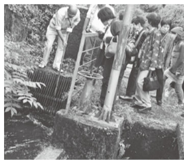
取水した水をヘッドタンクに引き込む様子
