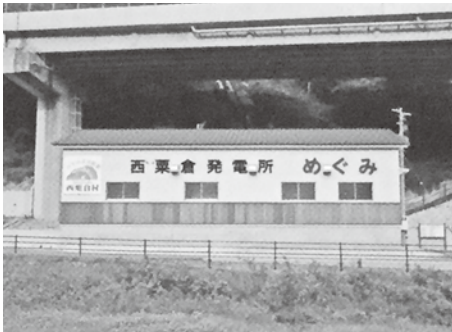
西栗倉村の小水力発電所「めぐみ」
