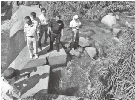
小水力発電所「めぐみ」の取水地
