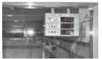
ゴミを消却する際に出る熱を利用して 発電を行っている
